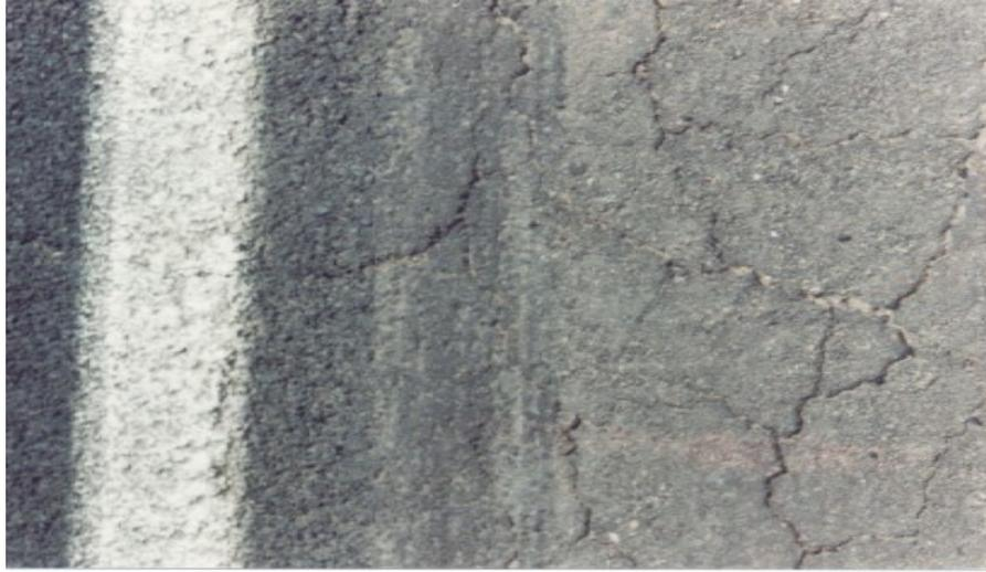
Figura 17 – Problemas de trincas no pavimento.
