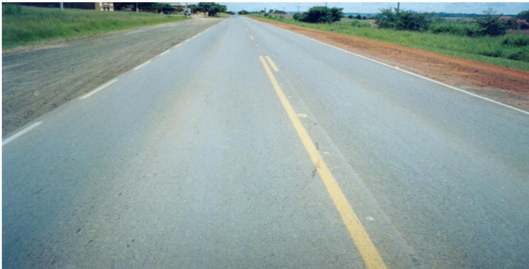
Figura 18 – Pista à direita recapeada sem resíduo, e à esquerda com 0,3% de resíduo.
